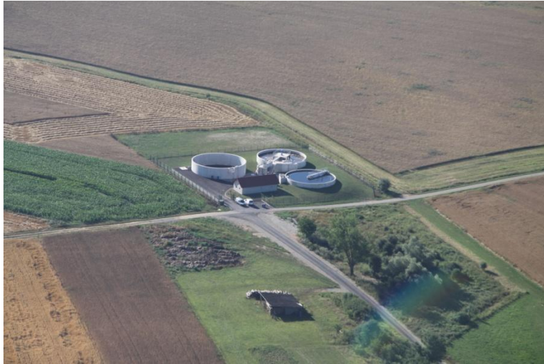
La station d'épuration
