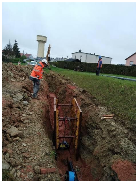
Renouvellement d'une conduite d'eau à Petit Réderching par l'entreprise SOTRAVEST
