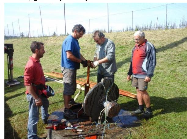
la pompe de l'arrosage du terrain, sortir 60 mètres de tuyaux du puits puis remplacer le moteur de la pompe et son installation électrique avec l'aide d'Hervé HOELLINGER remarquable...tant au niveau des coûts que du travail réalisé.
