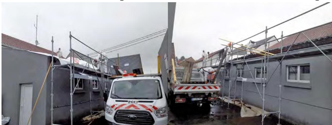
Dépôt arrière de la caserne des SP – Désamiantage et pose d'une nouvelle toiture (Malriat Bitche)
